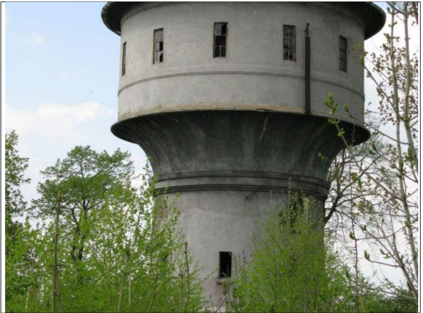
Wieża ciśnień Damastawek
